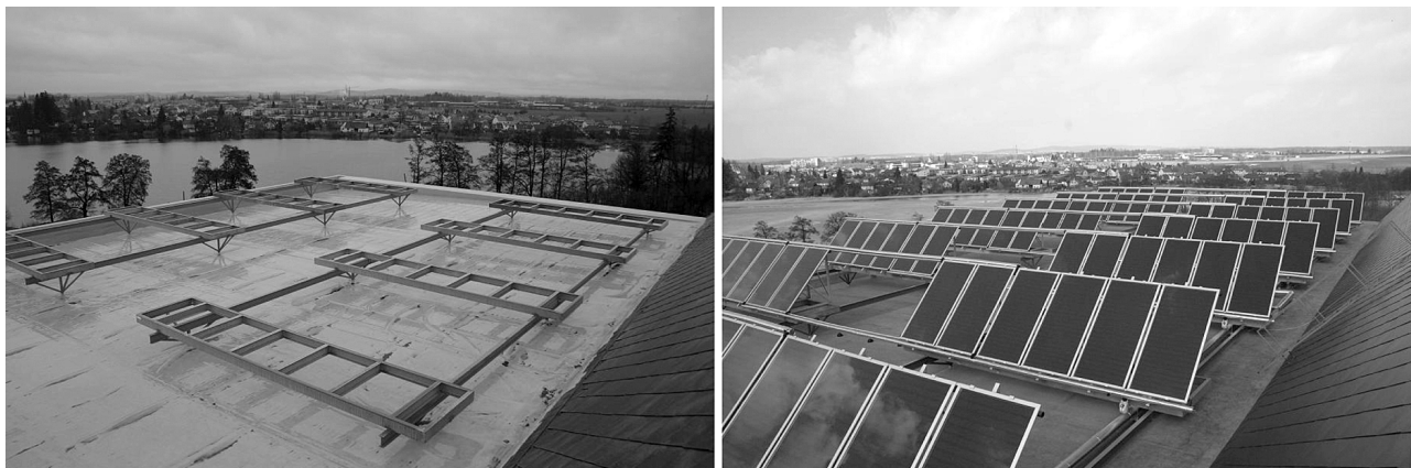
Obr. č. 12 - Příklad dělené nosné konstrukce
